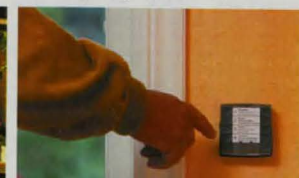
Centralstyrning av belysning...
